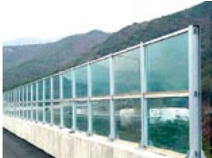
Rys. 2. Ekran akustyczny poliwęglanowy z powłoką fotokatalityczną o własnościach samooczyszczających [6]
