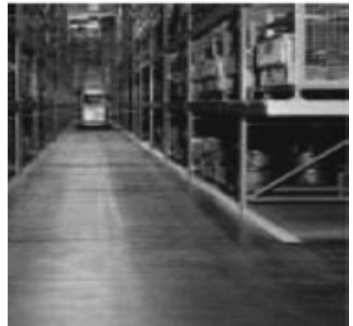
Rys. 2. Posadzka żywiczna uniwersalna, epoksydowa [8]
