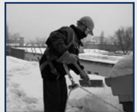
Fot. 1. Przykład stosowania systemu uniemożliwiającego rozpoczęcie spadania
