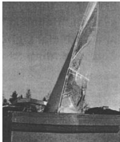
Rys. 8. Naświetlacz dachowy z heliostatem, rozpraszaczami piętrowymi i wmontowanymi elektrycznymi źródłami światła: z lewej - schemat ideowy, z prawej - widok z dachu budynku
