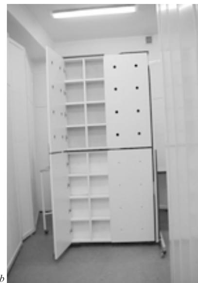
Rys. 1. Widok elementu panelowego ustroju rezonatorowego: a – bez wypełnienia, b – z wypełnieniem
