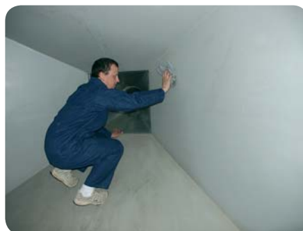
Fot. 1. Pozycja ciała oznaczona jako A przyjmowana podczas czyszczenia ścian bocznych kanału wentylacyjnego Photo 1. Body posture A when cleaning ducts
