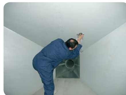
Fot. 2. Pozycja ciała oznaczona jako B przyjmowana podczas czyszczenia ściany górnej kanału wentylacyjnego Photo 2. Body posture B when duct cleaning
