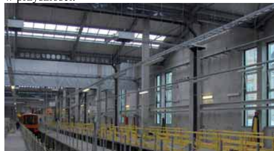
Przepusty i otwory wylotowe na dachu i w ścianach budynku pozwoliły na znaczną poprawę oświetlenia
