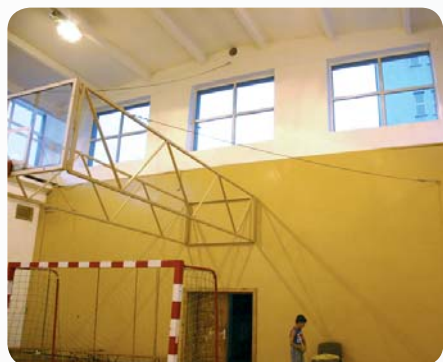
Fot. Zabezpieczenie konstrukcji mocującej tablicę do koszykówki linami zakotwionymi do ściany budynku Photo. Protection of basketball board with ropes anchored in the wall of the building
