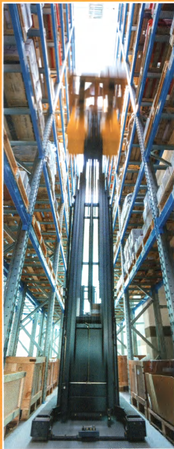
WYPADEK W MAGAZYNIE WYSOKIEGO SKŁADOWANIA
