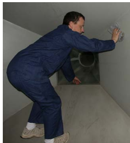
Fot. 6. Wcieranie środka konserwacyjnego w powierzchnię ściany – 2
