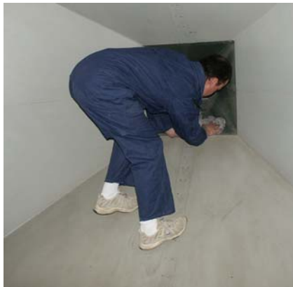
Fot. 2. Czyszczenie środkiem konserwującym w kanale wentylacyjnym
