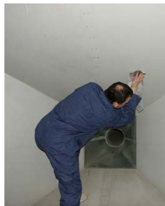
Fot. 7. Wcieranie środka konserwacyjnego w powierzchnię sufitu
