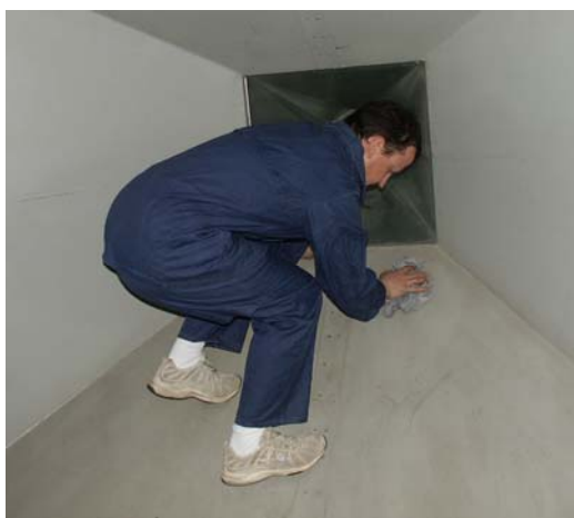
Fot. 4. Wcieranie środka konserwacyjnego w powierzchnię podłogi – 2
