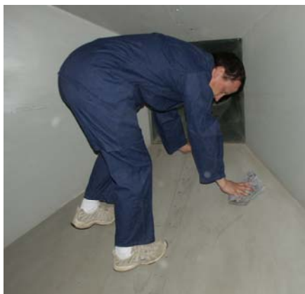
Fot. 3. Wcieranie środka konserwacyjnego w powierzchnię podłogi – 1
