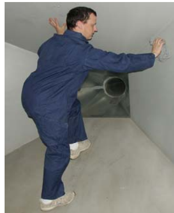
Fot. 5. Wcieranie środka konserwacyjnego w powierzchnię ściany – 1
